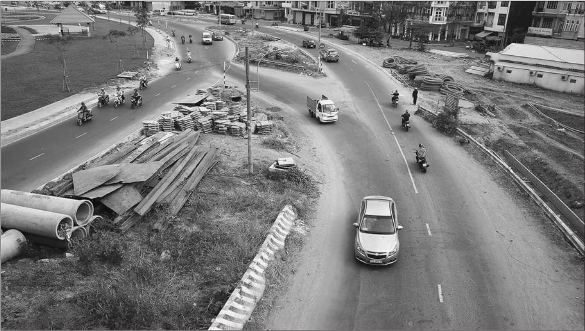
Đến hết năm 2017, các địa phương đã bố trí dứt điểm 100% nợ đọng xây dựng cơ bản còn lại Ảnh: TK
